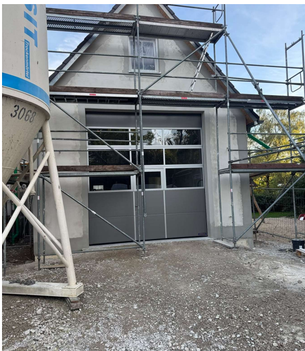
Anbau mit neuem Hallentor
