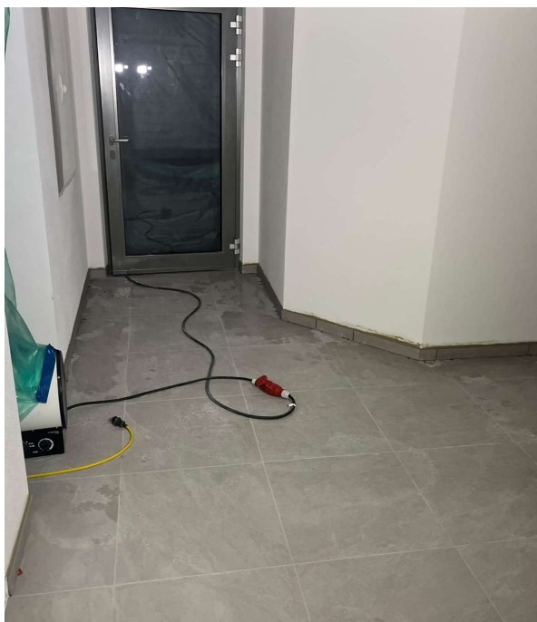
Flur zu den Umkleiden
